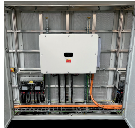
Strag Süd, GAK und Wechselrichter Huawei 100KTL
