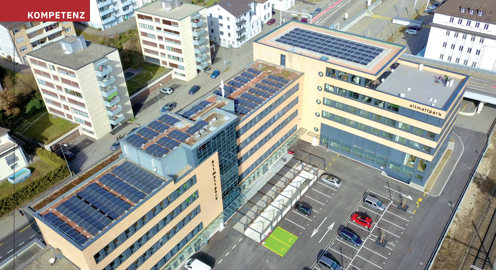
PVA Strag Nord mit 150 kWp
