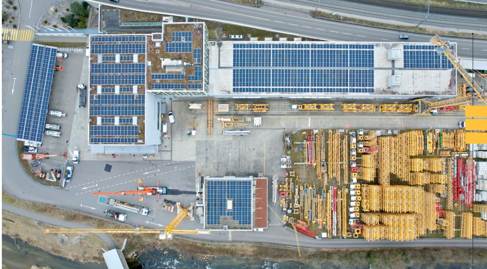
PVA Stirag Süd mit 460 kWp
